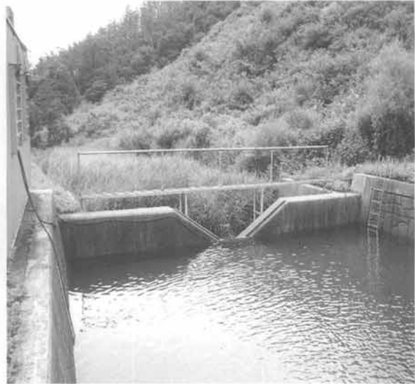
Fig. 2. 120° V-notch weir.
